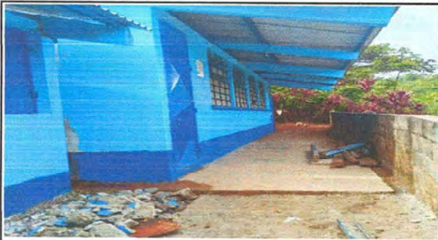
Foto 1: culminacion de la pintura en muro interior y exterior de todas las aulas del Centro Educativo.
