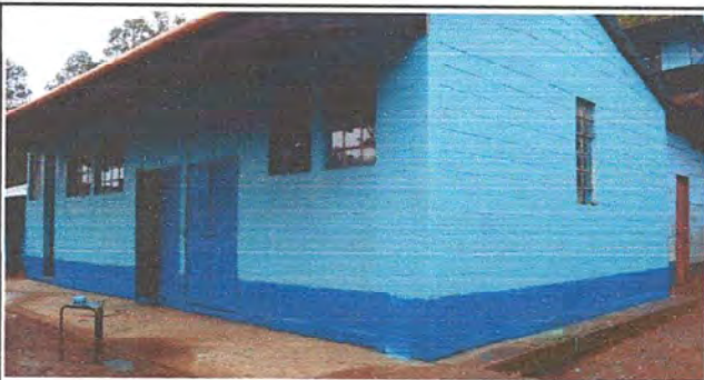
Foto 3: Culminacion del mejoramiento en puertas del Centro Educativo
