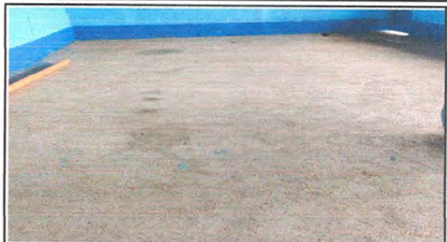
Foto 2: culminacion de la colocacion del piso en dos aulas del Centro Educativo.
