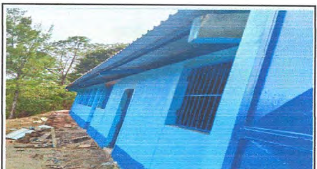
Foto 4: Verificacion de la culminacion y colocacion de ventanas y puertas en dos aulas del Centro Educativo
